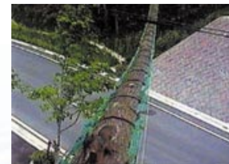
【動物の連絡ルートの例】 動物の移動経路の確保方策としてボックスカルバート、サル等の専用橋、リスのつり橋などを設置
