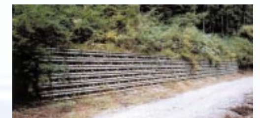
【間伐材利用の例】 地域資源の有効活用を図るため、間伐材を木製ブロックとして利用
