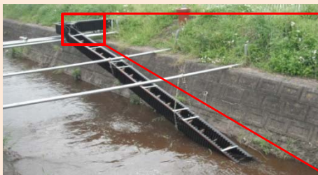
設置した水田魚道
