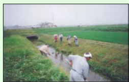
水路の泥上げ (日常の管理)
