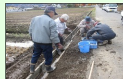
水路の補修 (施設の長寿命化)
