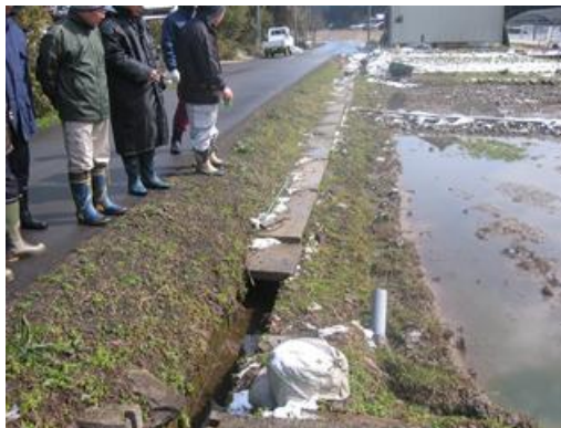
開水路の点検状況
