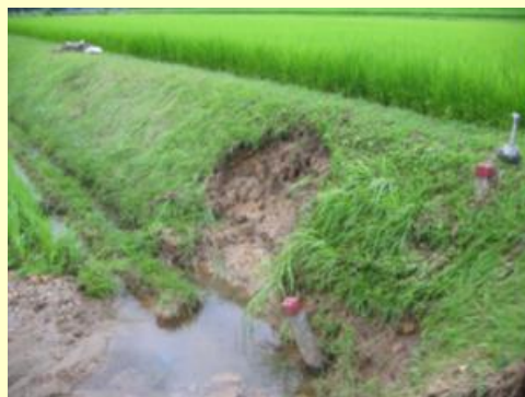
農用地法面が崩れた状況
