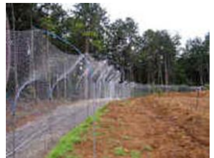
防護柵設置状況
