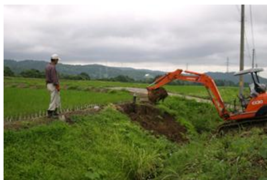
農用地法面の補修
