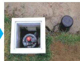
給水栓の自動化へ改良
