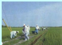
農道砂利補修作業
