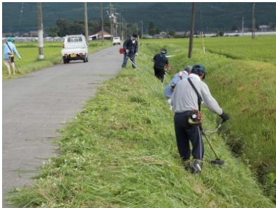
(法面の草刈り)
