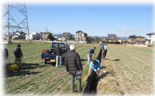
水路のひび割れ補修
