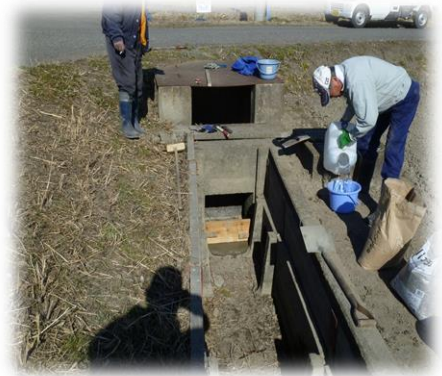
水路の堰の補修
