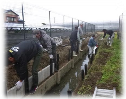
直営施工による 水路側壁の嵩上げ
