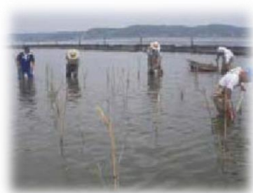
移植作業状況
