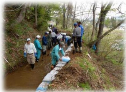
水路の崩壊箇所の補修
