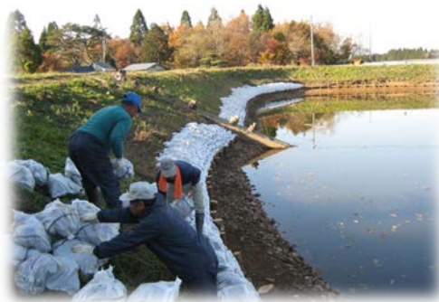
ため池堤体の補強
