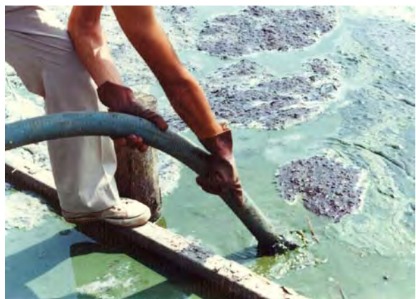
写真 岸辺に吹き寄せられたアオコをバキュームカーで吸い取っている様子
