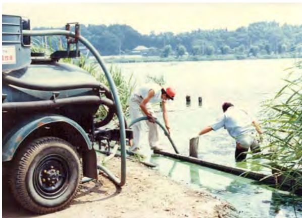
写真 岸辺に吹き寄せられたアオコをバキュームカーで吸い取っている様子
