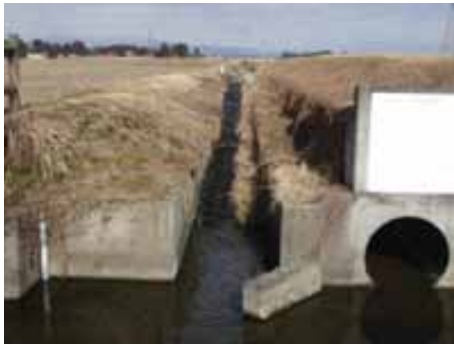
水路の全段面に施工した例 （栃木県 西鬼怒川地区）
