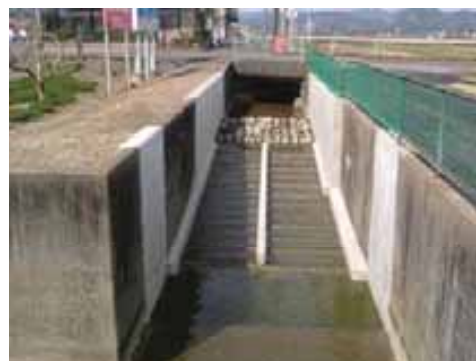
粗石付斜路式と組み合わせた複合式 （岐阜県本巣市 糸貫地区）
