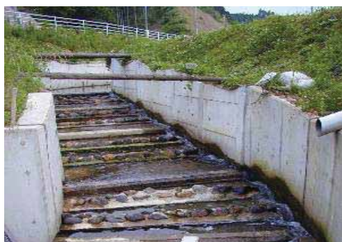
階段部分に自然石を付けた例 （千葉県長南町 埴生川3期地区）
