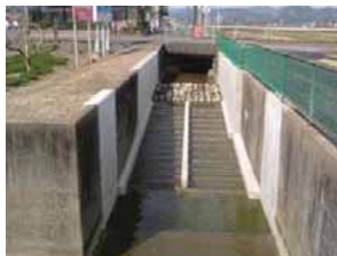
粗石付斜路式と組み合わせた複合式 （岐阜県本巣市 糸貫地区）
