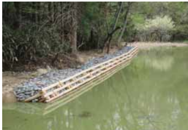
木材と石を組み合わせることによって、生物の生息空間となる空隙を確保します。（岩手県奥州市 沢堤地区）
