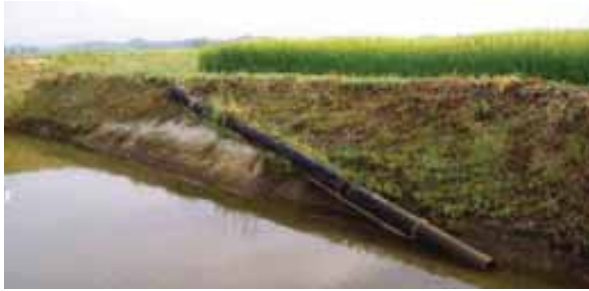
露出型の設置例 （宮城県 伊豆沼周辺）
