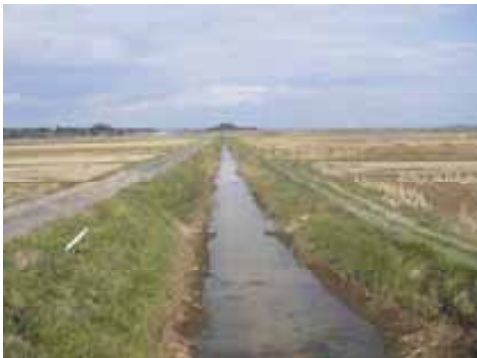
両岸の勾配を緩くした事例。水鳥等の横断にも配慮しています。（宮城県 伊豆沼周辺）
