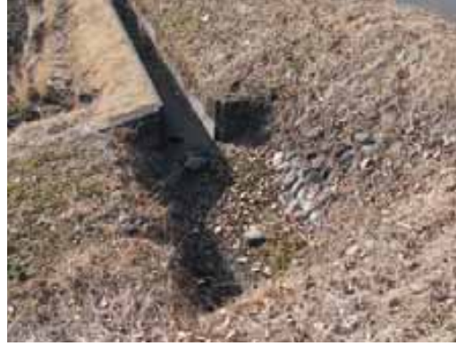
這い上がり用に設置したコンクリート製スロープ（左）と、玉石付きスロープ（右）
