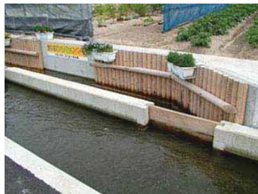
間伐材を使用して施工した例 （島根県斐川町 砂川地区）
