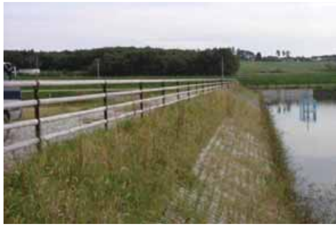
皿池等、勾配が緩やかなため池において施工します。 （宮城県登米市 板橋地区）
