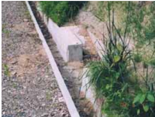
這い上がり用に設置したコンクリート製スロープ（左）と、玉石付きスロープ（右）
