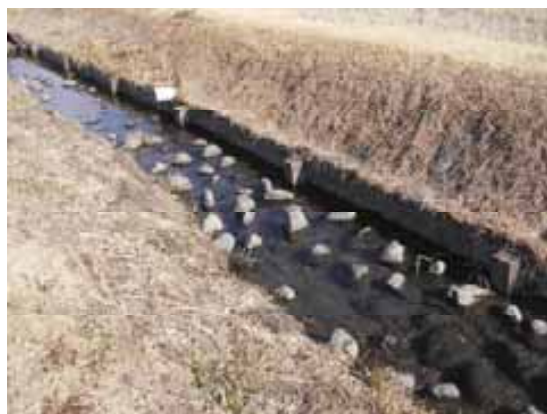
置石工（栃木県 西鬼怒川地区）
