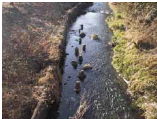
乱杭工（栃木県 西鬼怒川地区）
