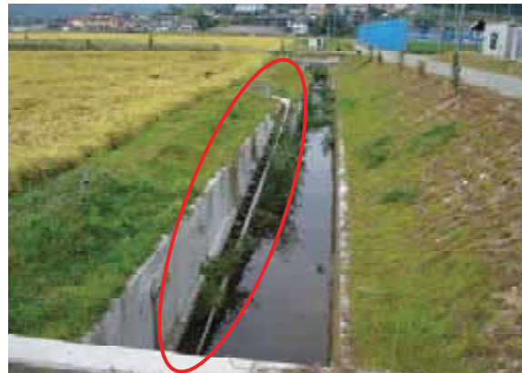
（広島県世羅町 川尻地区）
