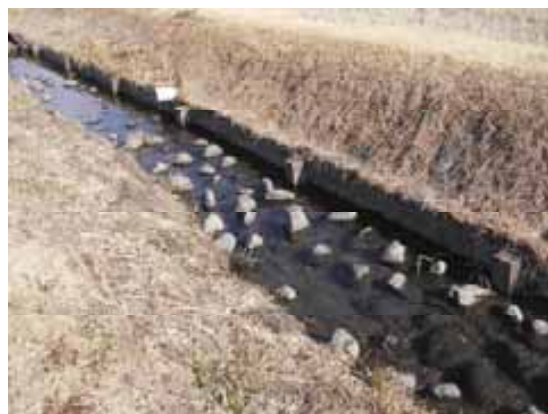
置石工（栃木県 西鬼怒川地区）
