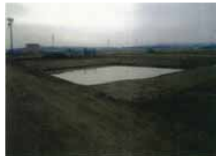
魚類の生息環境の向上のための保全池 （宮城県 北赤井地区）
