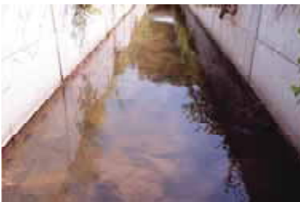
水路底部に空間のあるブロックを配置した例（高知県四万十市 安並地区）
