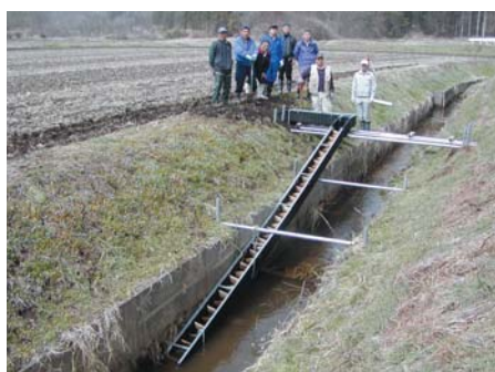
(栃木県宇都宮市上篠井) 水田と水路の落差を解消した「魚道」 (写真提供：メダカ里親の会 中茎元一氏)
