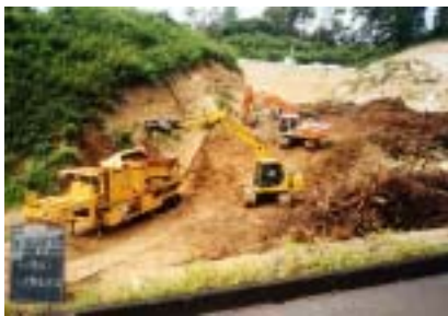
伐採後の根株等を現場で、自走式破砕機でチップにしている状況
