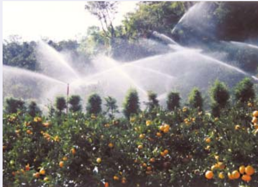
国営の施設から送水された水を、県営かんがい排水事業で整備したスプリンクラーで散水する
