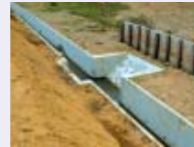
生きものの用の脱出スロープが施されている
