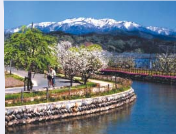
二ノ堰の背景には月山が見える。柵は木製。案内板も設置されている
