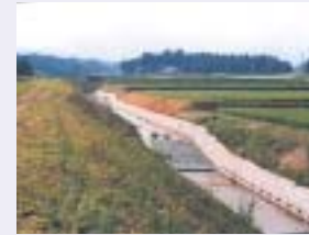
階段式落差工が施された排水路
