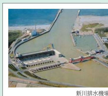
新川排水機場
