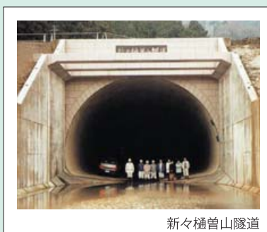
新々樋曾山隧道
