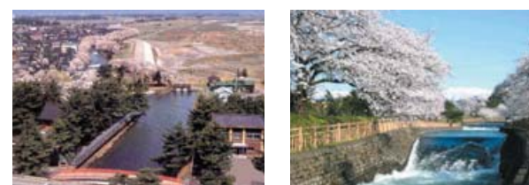
地域の景観に配慮して改修された常西合口用水路と桜並木
