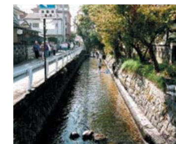
水草を回復させるとともに自然石を用いることで景観と生態系に配慮し、整備された水路
