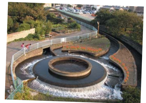
群馬県高崎市 長野堰用水 円筒分水堰 (写真提供: 水土里ネット「疏水名鑑」)
