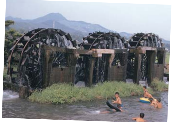
福岡県朝倉市 堀川用水 三連水車 (写真提供: (社)農村環境整備センター第5回「私の好きな日本の農村」フォトコンテスト佳作「夏の思い出」谷口公一)
