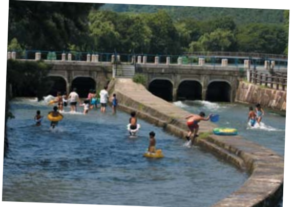
岡山県倉敷市 東西用水 南配水樋門 (写真提供: 水土里ネット「疏水名鑑」)
