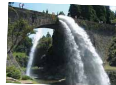
熊本県山都町 通潤用水 通潤橋 (写真提供: 水土里ネット「疏水名鑑」)
