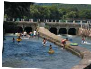
岡山県倉敷市 東西用水 南配水樋門 (写真提供: 水土里ネット「疏水名鑑」)
