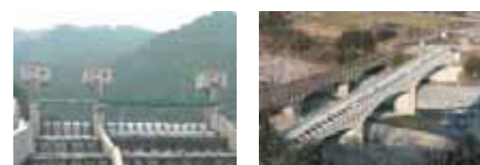
水の流れが白濁に見える江江頭首工 従前の景観を継承して作られる左岸連絡水路橋
