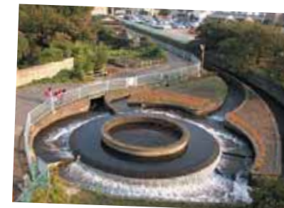
群馬県高崎市 長野堰用水 円筒分水堰 (写真提供: 水土里ネット「疏水名鑑」)
