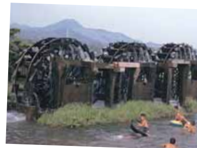
福岡県朝倉市 堀川用水 三連水車 (写真提供: (社)農村環境整備センター 第5回「私の好きな日本の農村」フォトコンテスト佳作「夏の思い出」谷口公一)
