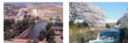
地域の景観に配慮して改修された常西合口用水路と桜並木
