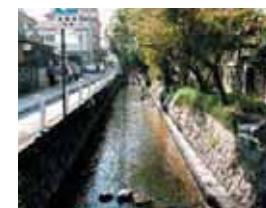
水草を回復させるとともに自然石を用いることで景観と生態系に配慮し、整備された水路
