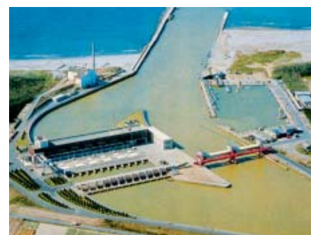
④ 排水機場
