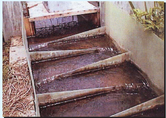
底生魚(ドジョウ)や遊泳魚(メダカ)も遡上可能な魚道。
