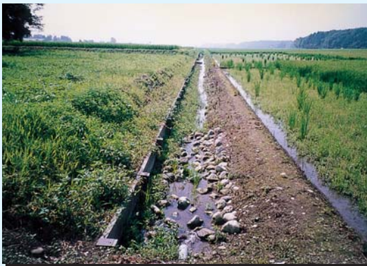
排水路と水田をドジョウが行き来できるように「どじょう水路」を設置しました。
