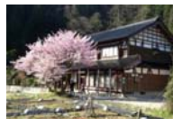
古民家等の改修
