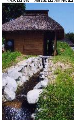
農業用施設(水車小屋・石積み水路)を整備・復元 <岩手県 東和地区>
