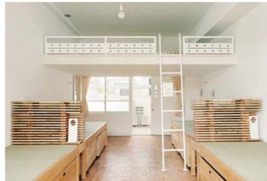
平成16年度 やすらぎ空間整備事業(旧事業) 廃校の改修(宿泊室) ＜新潟県・上越市(旧浦川原村)＞
