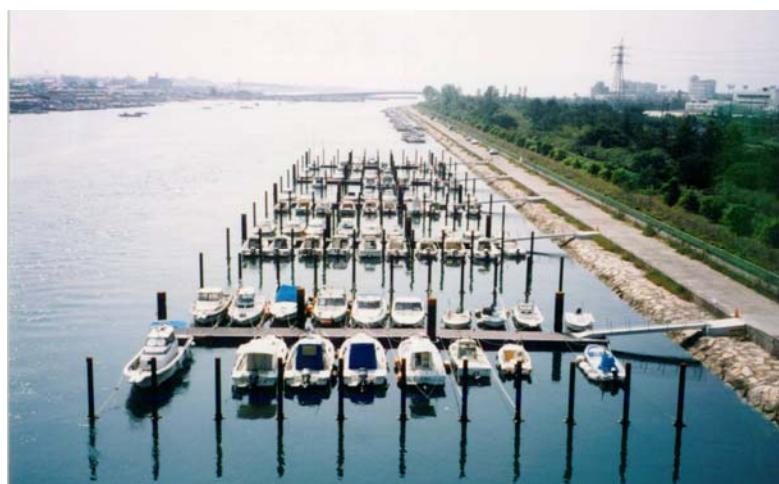
水上保管施設整備
