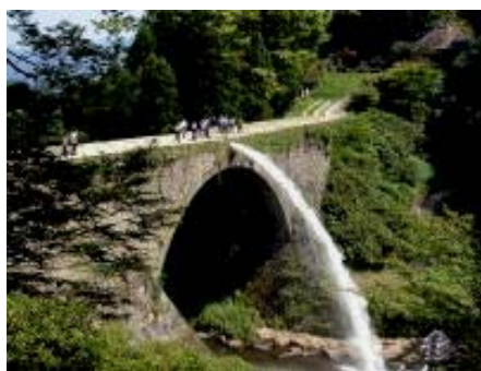
通潤橋を改修し、地域のシンボルとして活用 <熊本県 矢部町 通潤橋地区>
