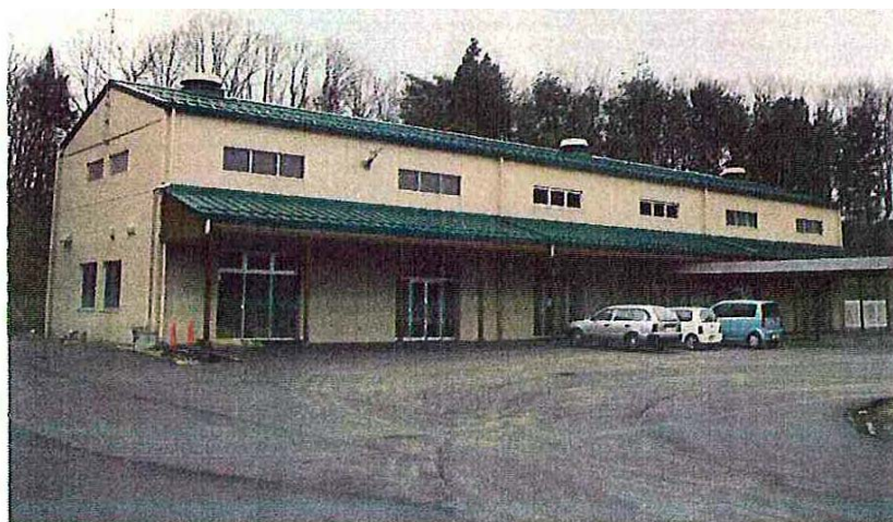
廃工場を宿泊施設として改修<新潟県西山町>
