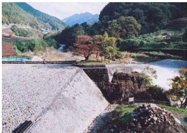
砂防施設と一体となった周辺整備を実施 <山梨県甲州市勝沼町の勝沼砂防堰堤>
