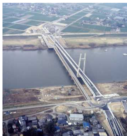
交流ふれあいトンネル橋梁整備
