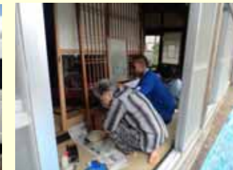
海外研修生と古民家再生作業
