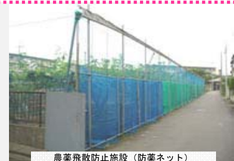
農薬飛散防止施設(防薬ネット)
