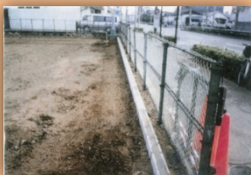
土留工等の簡易な基盤整備
