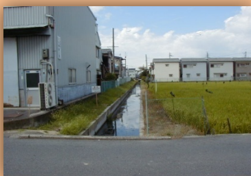
用水路補修等の簡易な基盤整備
