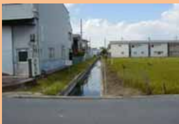
用水路補修等の簡易な基盤整備
