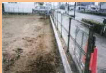
土留工等の簡易な基盤整備
