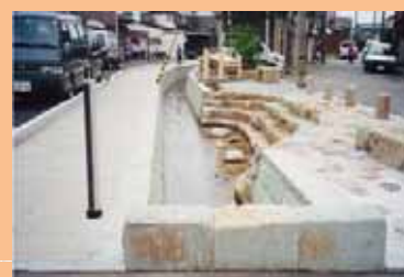
親水護岸等の水辺環境整備
