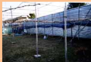
農業飛散防止施設等の 簡易な施設整備
