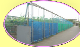
農薬飛散防止施設
