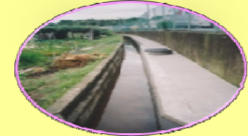
用水路の新設・改修
