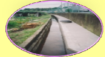
用水路の新設・改修
