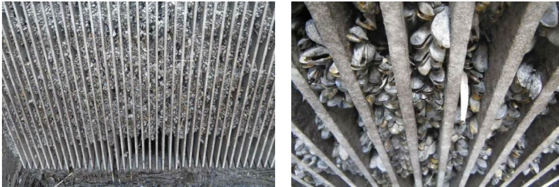
写真-7. 参2 スクリーンに付着したカワヒバリガイ
