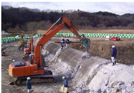
劣化表層コンクリートのはつり
