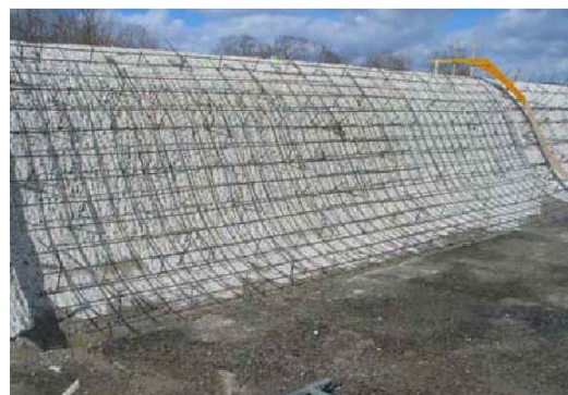
補強鉄筋組み立て
