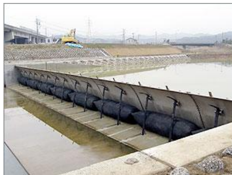
【S R 堰の全体写真】
