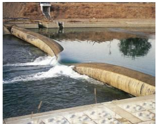
【ゴム堰のＶノッチ現象の例】
