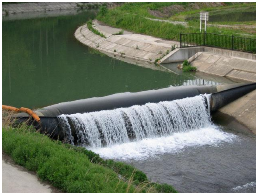
【ゴム堰を単独で水路に設置した例】
