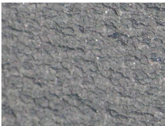
写真 2.1.3 袋体外面劣化部の拡大写真
