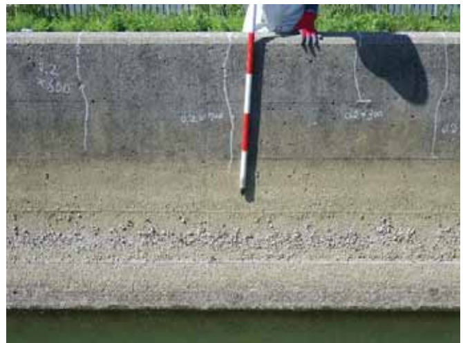
図 3. 2-1 乾燥収縮ひび割れの発生イメージ
