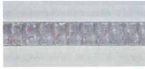
腐食度区分：A 又は I
