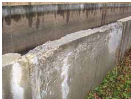
図 3.3-9 目地部に生じる特徴的な凍害
