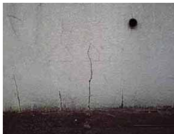
図 3. 2-4 温度ひび割れの発生イメージ
