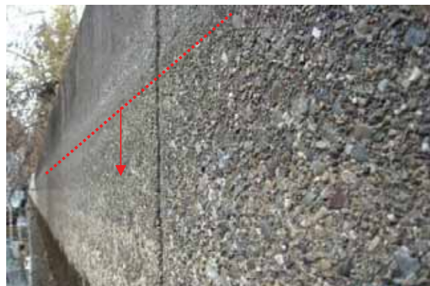
図 3. 3-2 喫水線下部に生じた摩耗
