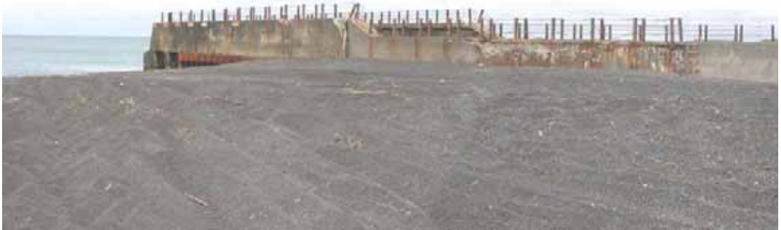
図 3.3-36 塩害が生じている施設の事例（施設全景）
