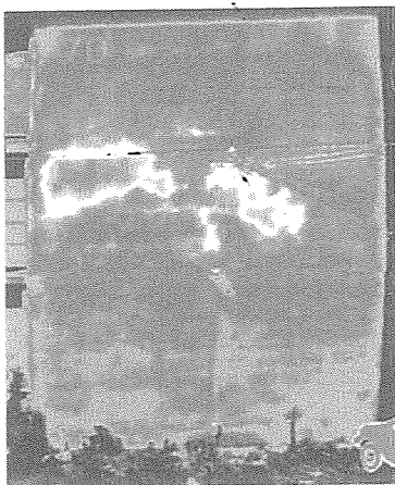
写真 3.6.1-2 モルタル浮き部の調査事例
