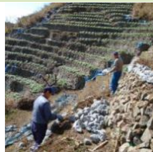
石垣の修復の様子
