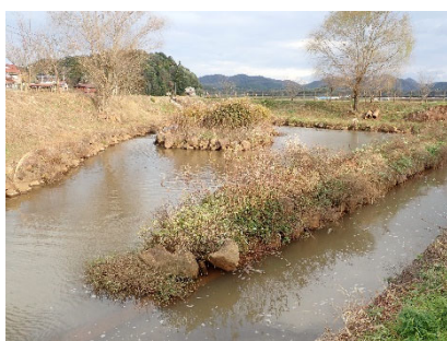
幹線排水路に設置したビオトープ
