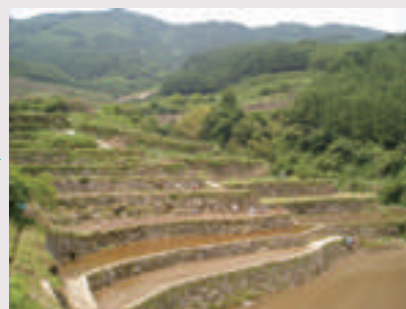
復旧後の棚田
