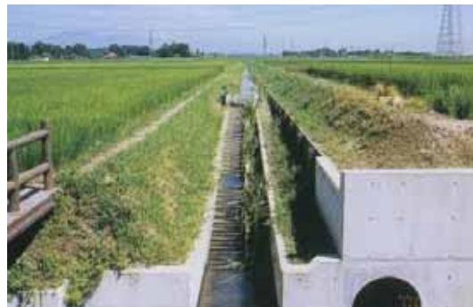
幹線排水路と土水路を連結するための小規模な魚道 (千鳥X型)(栃木県)。
