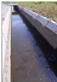
側部と底部が舗装されている コンクリート水路
