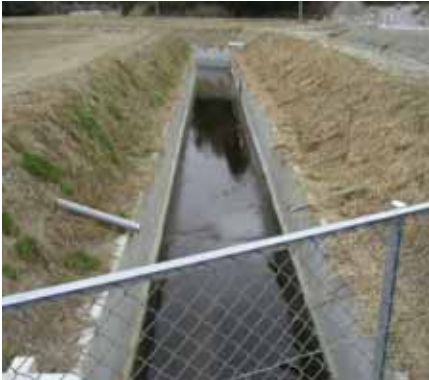
深く掘り下げられ、コンクリートで護岸された排水路 (水路と水田の水面の高さの差が大きくなると、生物の移動が困難になります。)
