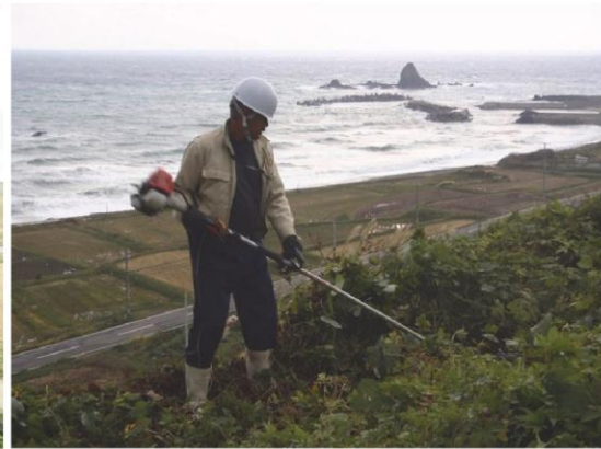
写真4 草刈り作業前後の現地状況 8月（写真左上）には草本に覆われていたが、草刈り作業後（写真左下：11月撮影）はアンカー工及びその周辺の点検が可能になった。 写真右上は地元多面的機能支払組合による草刈り作業の状況。
