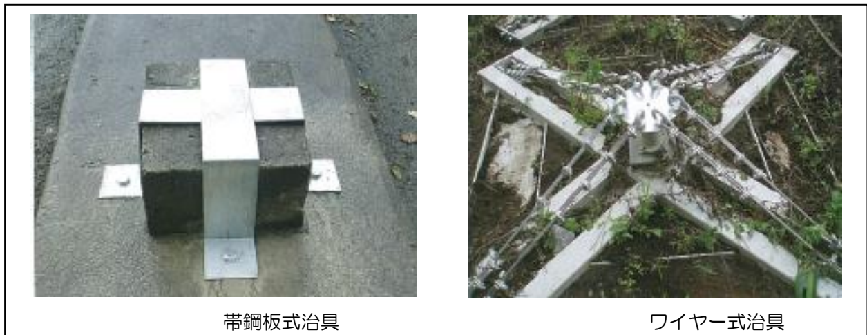
図 2-6 テンドンの飛び出し防止対策の例
