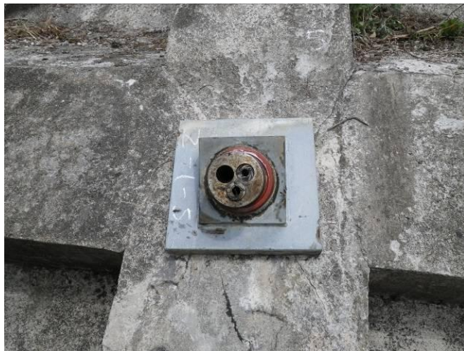
図 2-24 テンドンの引き込まれの事例
