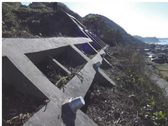
写真4 草刈り作業前後の現地状況 8月（写真左上）には草本に覆われていたが、草刈り作業後（写真左下：11月撮影）はアンカー工及びその周辺の点検が可能になった。 写真右上は地元多面的機能支払組合による草刈り作業の状況。
