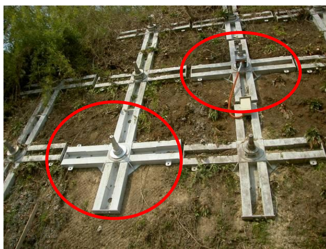
図 2-7 再設置されたアンカーの例
