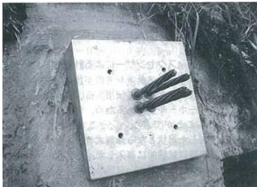
左：テーパプレートにくさび用の穴を設置したアンカーヘッド一体型支圧板事例 右：支圧板にネジ穴加工を行い、そこにネジ式のアンカーヘッドを取り付けた事例
