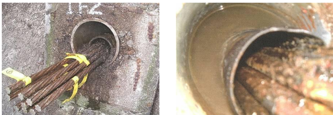
図 2-27 頭部背面の異物等混入の事例
