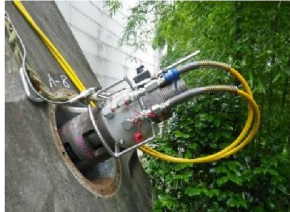
小型軽量ジャッキによるリフトオフ試験
