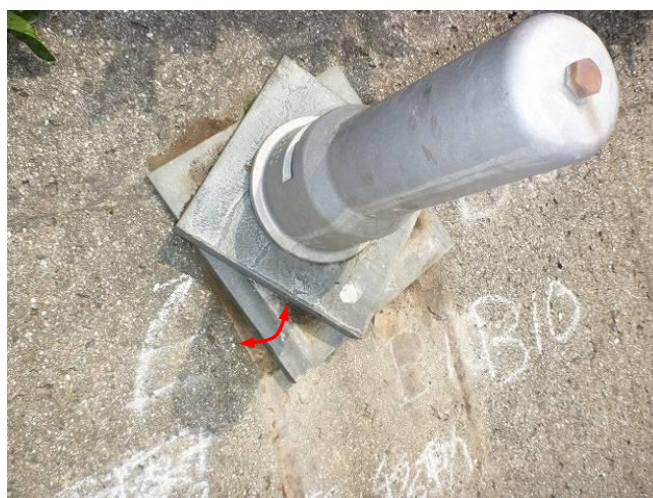
図 2-15 プレートが人力で回転可能な事例
