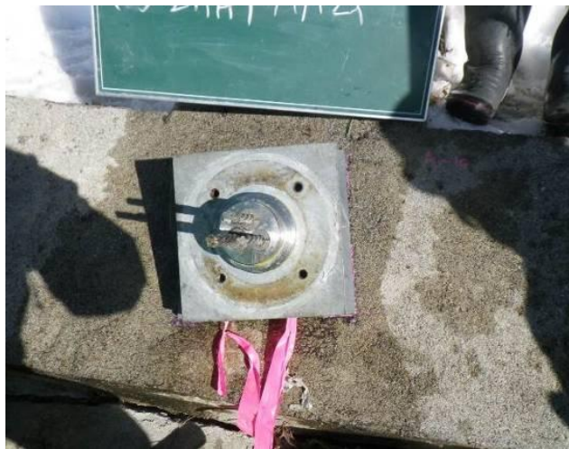
図 4-1 頭部露出調査例
