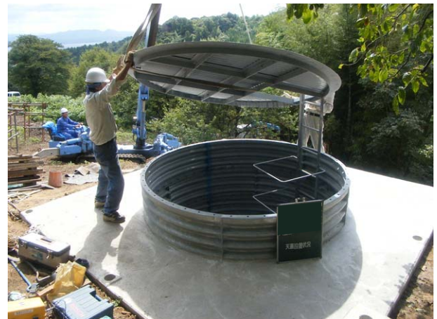
天蓋設置状況
