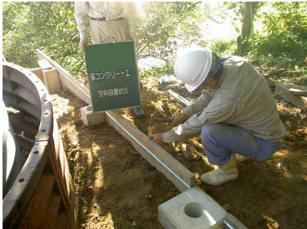
張コンクリート工型枠設置
