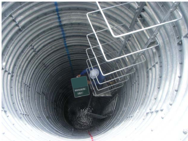
点検梯子設置状況
