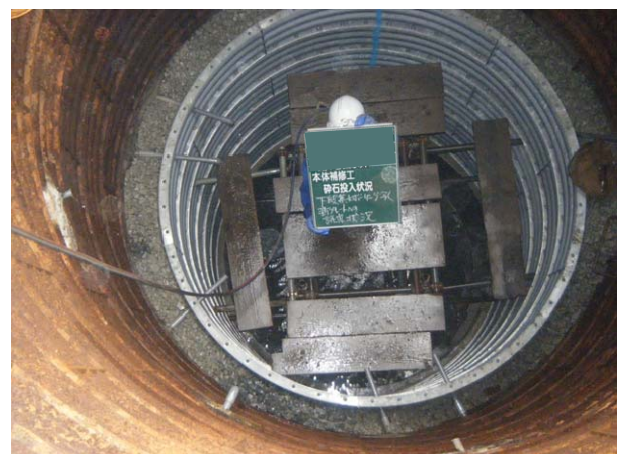
パイプ類接続状況
