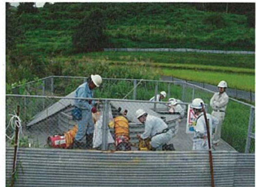
図-3 火山性ガス測定状況
