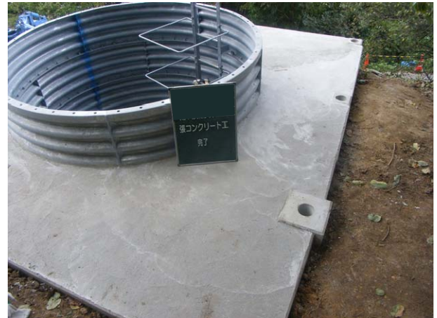
張コンクリート設置完了
