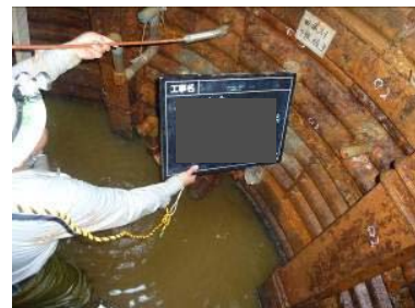
孔内カメラ測定状況
