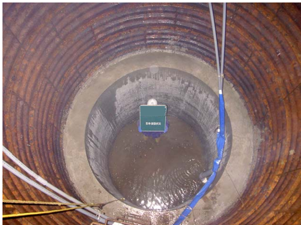
底盤コンクリート設置完了
