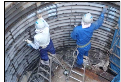
図3 集水井内塗装作業状況
