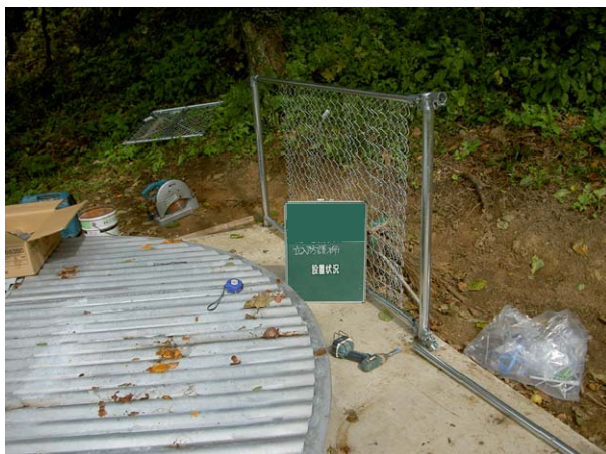
安全柵取付状況
