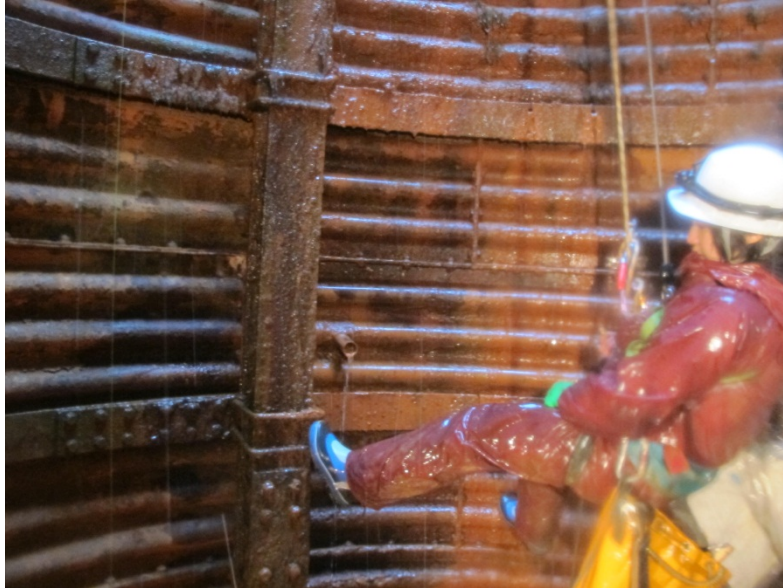
図-3 懸垂下降による詳細調査事例
