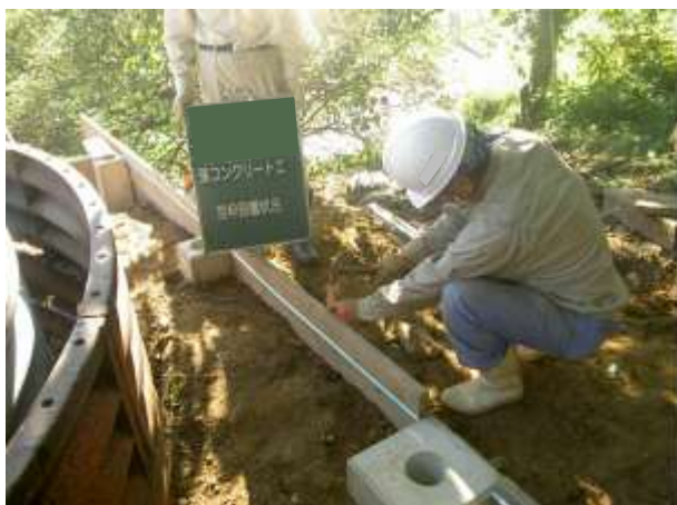
張コンクリート工型枠設置
