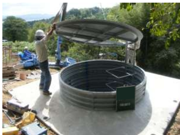
天蓋設置状況
