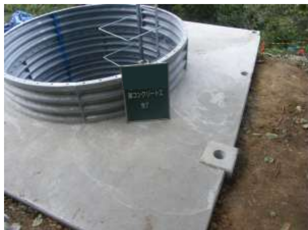
張コンクリート設置完了
