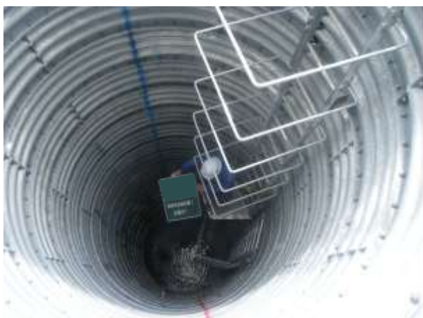
点検梯子設置状況
