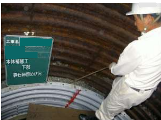
裏込め砕石締固め
