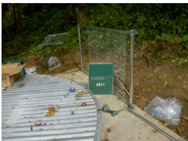
安全柵取付状況
